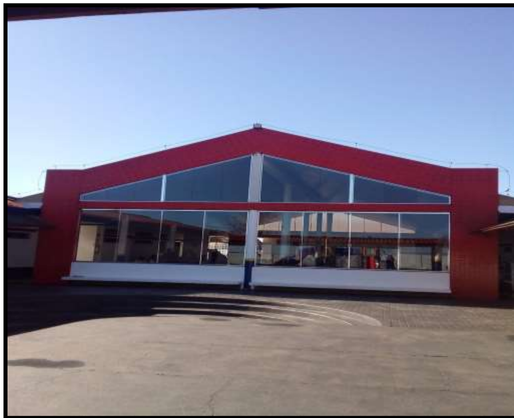
Fechamento do refeitório com portas e janelas de vidro CMEI Professora Valéria Pianaro.
