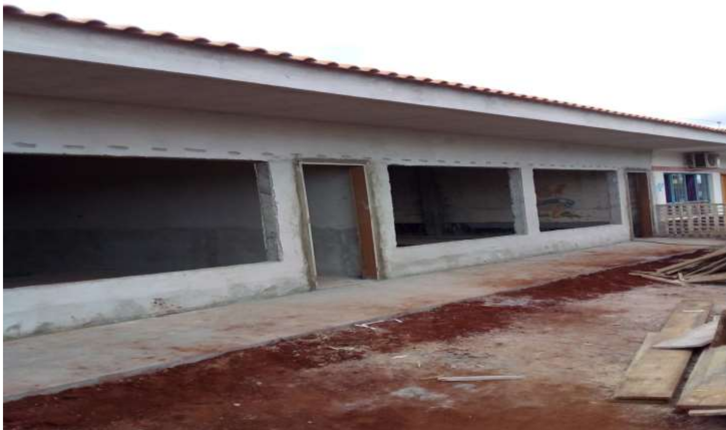
Construção de salas de aula.
