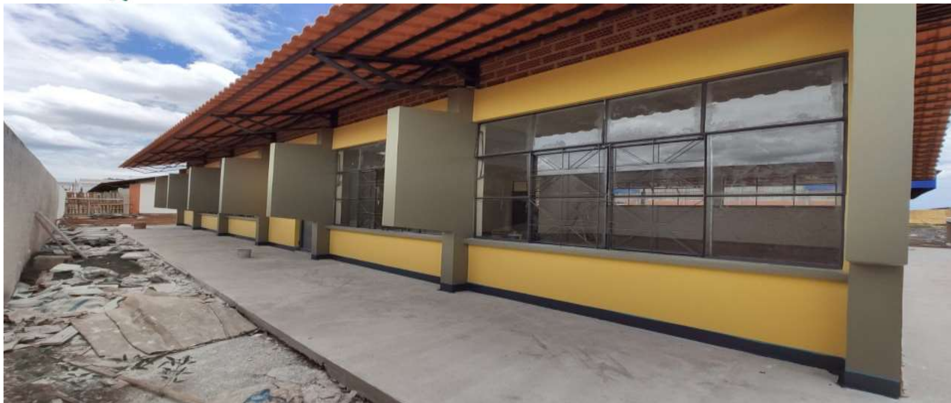
Construção de salas de aula.
