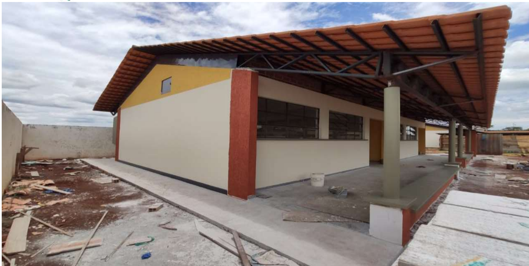
Construção de salas de aula.
