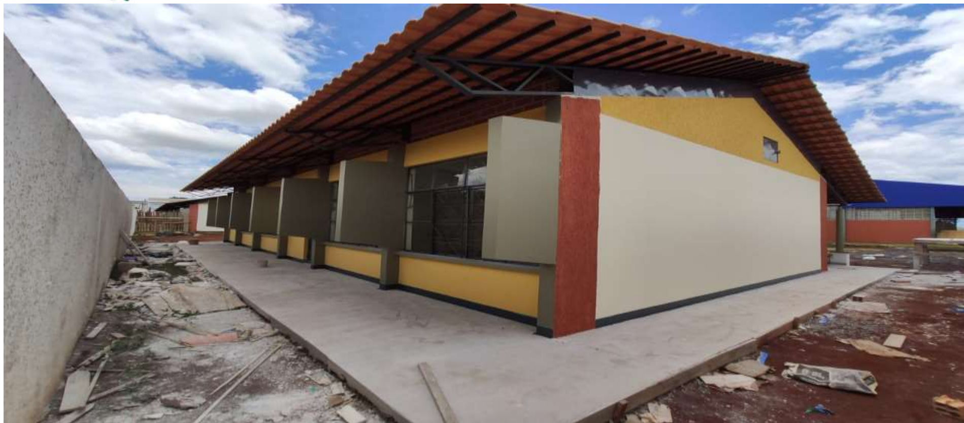
Construção de salas de aula.
