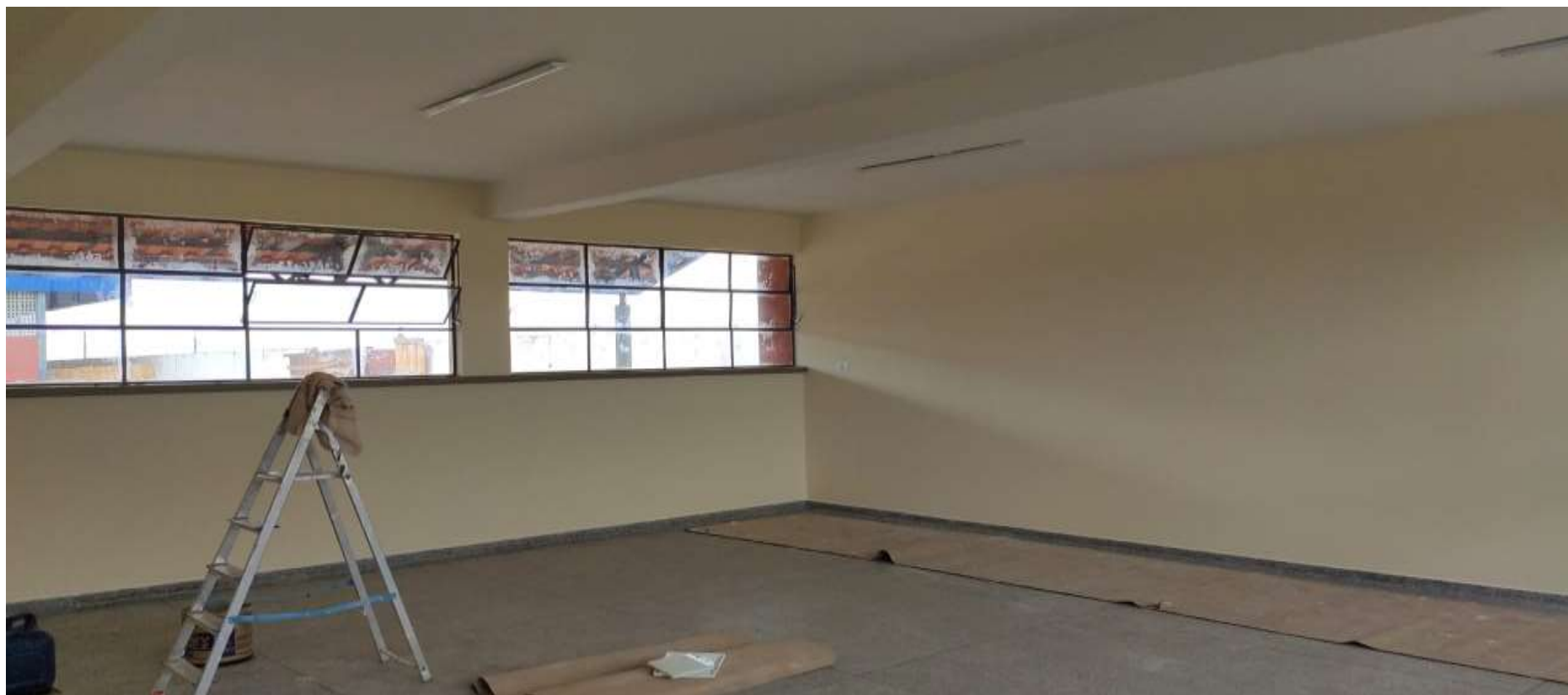
Construção de salas de aula.
